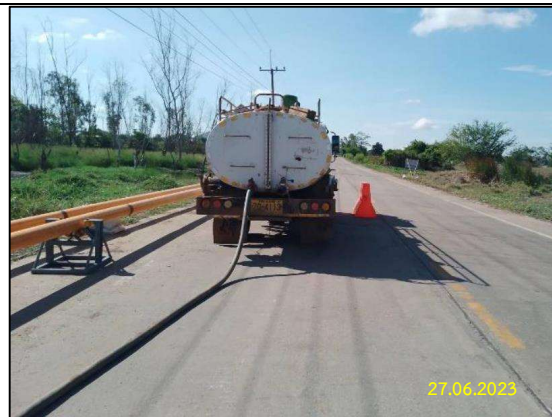
จ) การจัดเก็บโคลนโซเดียมเบนโทไนท์ที่รั่วไหลขึ้นในบริเวณพื้นที่ใกล้เคียง
