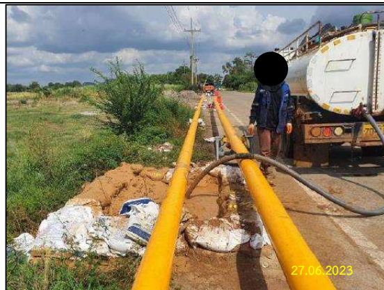
จ) การจัดเก็บโคลนโซเดียมเบนโทไนท์ที่รั่วไหลขึ้นในบริเวณพื้นที่ใกล้เคียง
