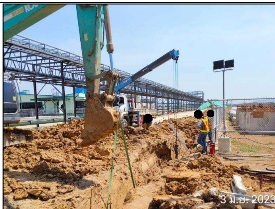
การเปิดพื้นที่ก่อสร้าง และการกลับท่อทันทีภายหลังการวางท่อแล้วเสร็จ
