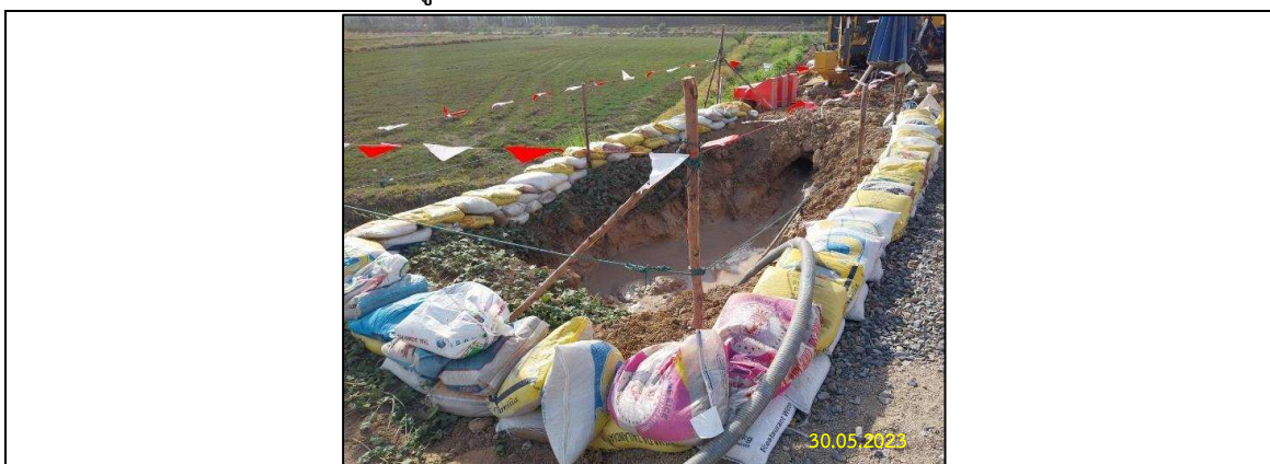
รูปที่ 2-9 การจัดวางถุงทรายหรือจัดทำคันดินกั้นรอบพื้นที่ป่อรับ-ป่อส่ง
