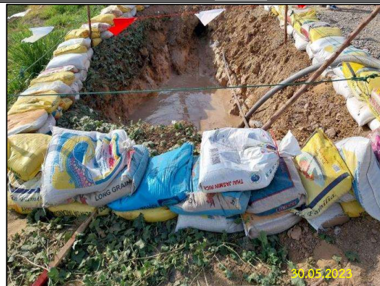
ข) จัดวางถุงทราย และจัดทำคันดินรอบพื้นที่บ่อรับและบ่อส่ง
