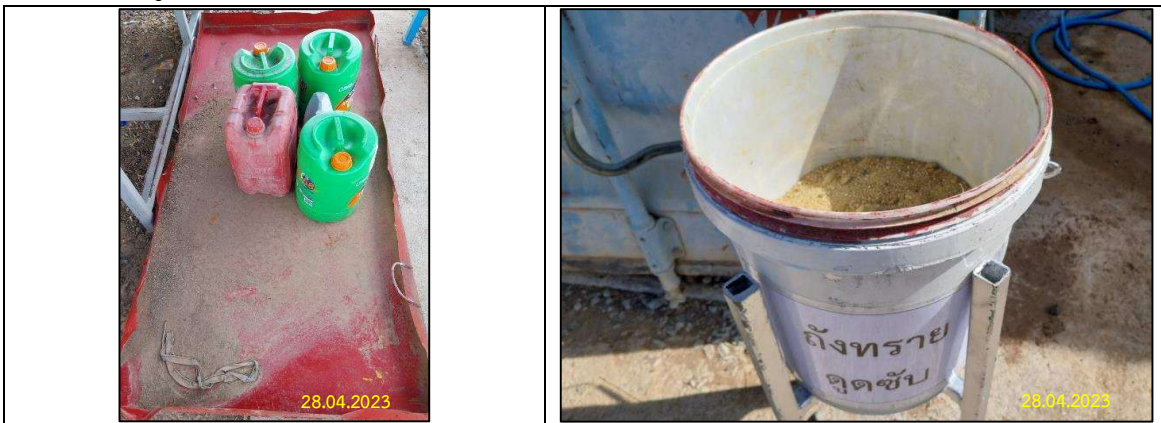
รูปที่ 2-11 การจัดเตรียมถาดเก็บและรองรับน้ำมัน พร้อมวัสดุดูดซับ
