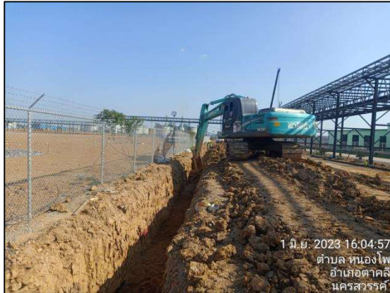
การเปิดพื้นที่ก่อสร้าง และการกลับท่อทันทีภายหลังการวางท่อแล้วเสร็จ
