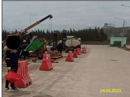
ติดตั้งวัสดุกันโดยรอบเขตพื้นที่ก่อสร้าง
